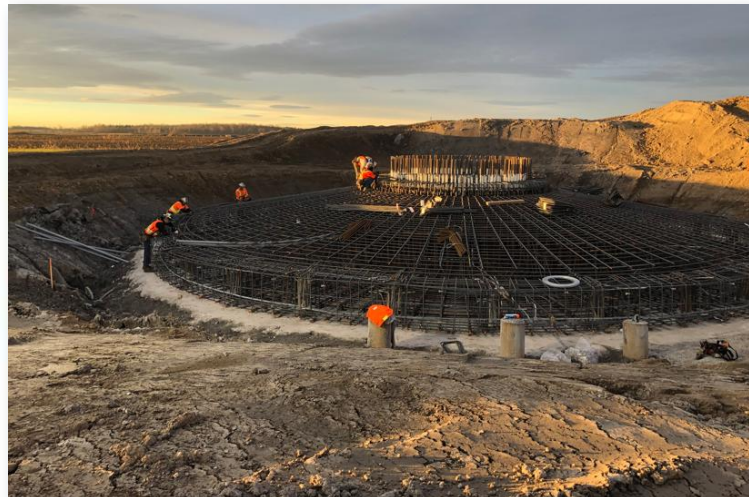
Installation de l'armature
