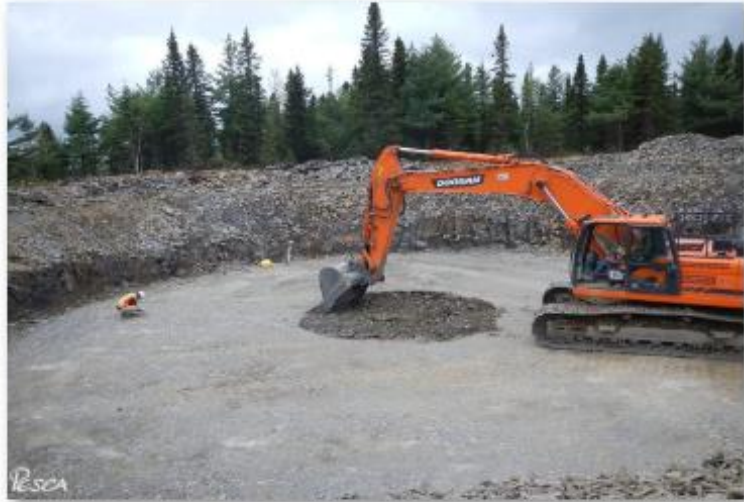
Excavation de la fondation
