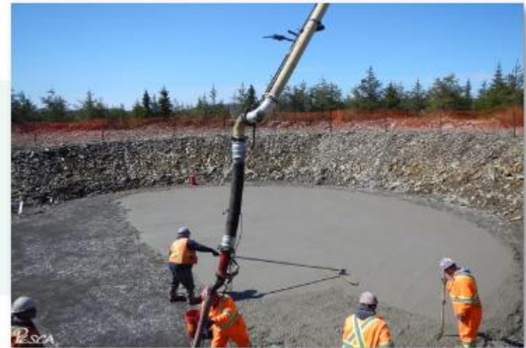
Coulage du béton
