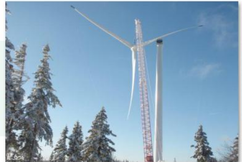
Installation du rotor
