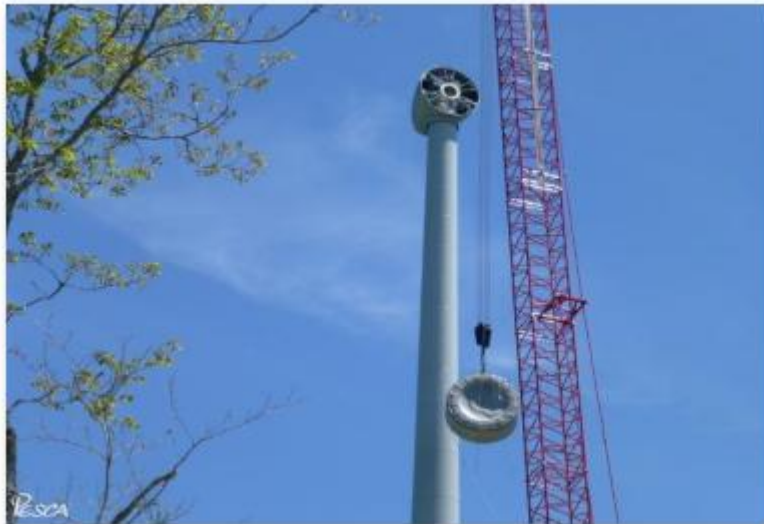
Mise en place de la nacelle
